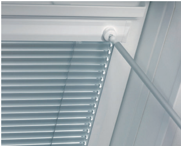
Lamellenwendung durch optionalen Bedienstab für schwer erreichbare Dachfenster.
